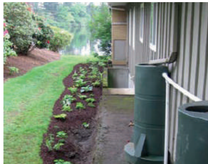
Exemples de récupération des eaux pluviales par citernes de stockage
