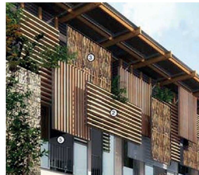
Brise soleil en sections diverses en cryptoméria
