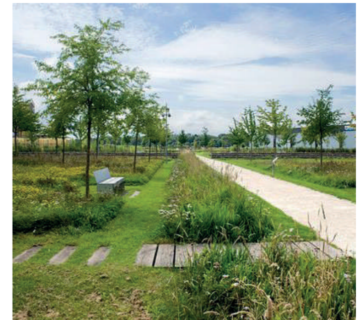
Exemple d'une noue plantée
