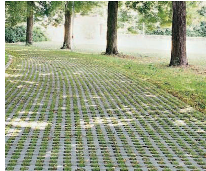
dalles alvéolaires béton et engazonnement
