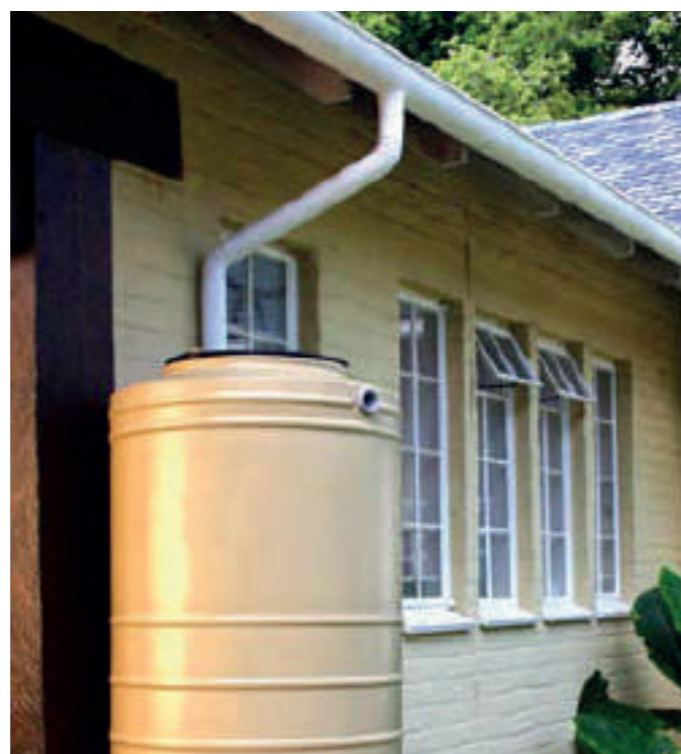
Exemples de récupération des eaux pluviales par citernes de stockage
