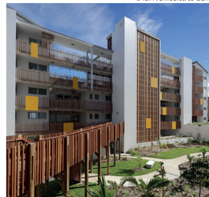
© Néo Architectes, Canopée
