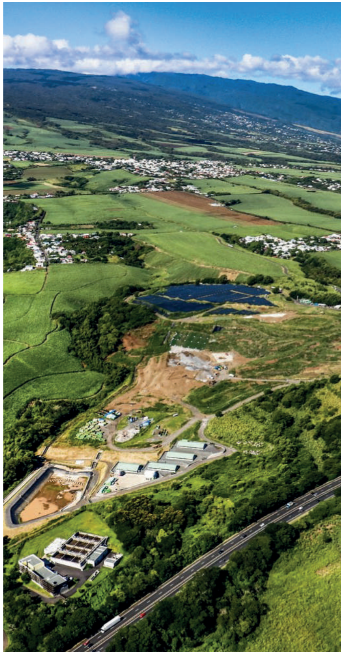
Nouveau centre de tri multi-filière à Bagatelle, source Inovert
