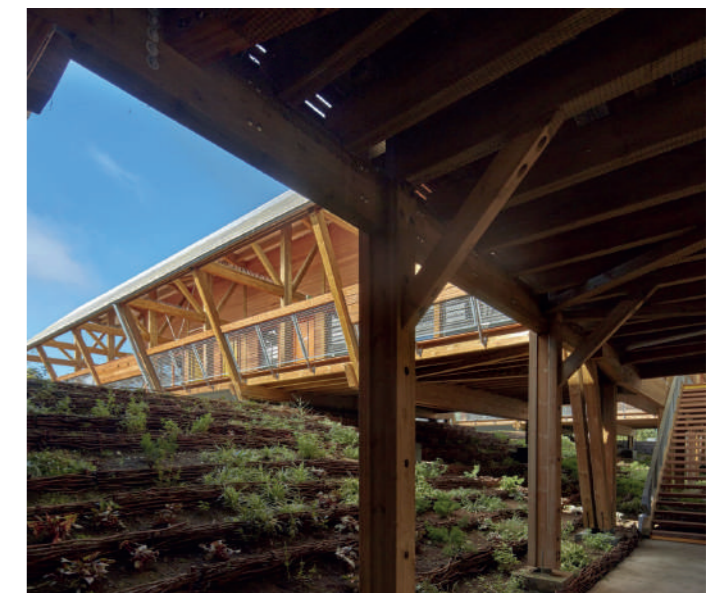
Le goyavier est idéal en fascines pour réaliser des terrasses paysagères
