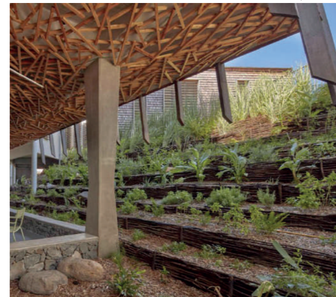
Le goyavier est idéal en fascines pour réaliser des terrasses paysagères
