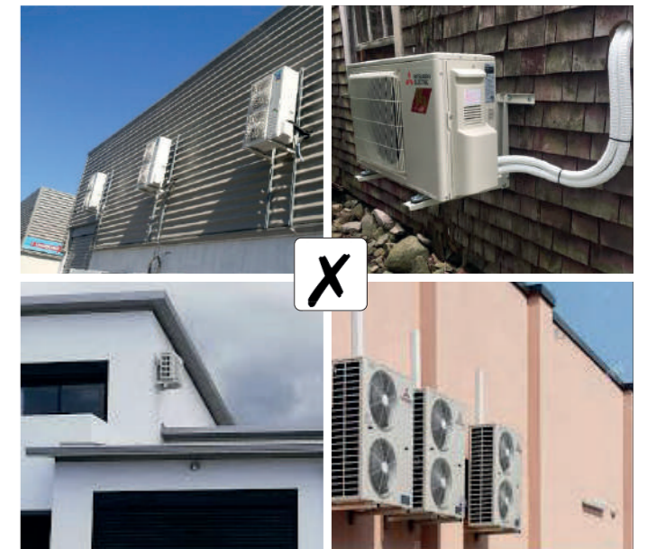
Des exemples de mises en oeuvre inesthétiques à exclure
