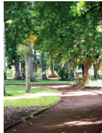
Comme dans le jardin de l'Etat à St Denis, les cheminements en scories peuvent donner un caractère à l'espace grâce à sa couleur et permet une dépermeabilisation du sol réduisant son insolation
